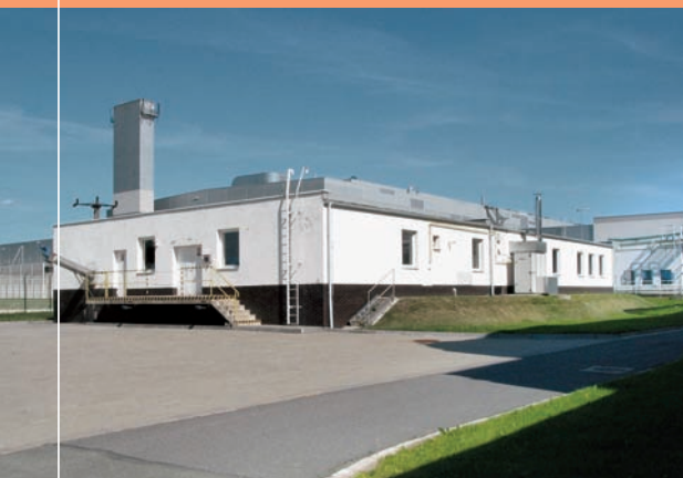
Moderní biologická čistirna odpadních vod s lakovnou karosérií v pozadí v závodě Kvasiny
