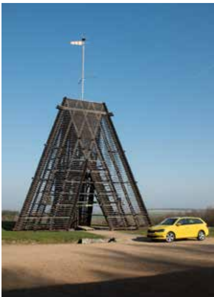
Nová zpevněná a důkladněji ukotvená verze architektonicky pozoruhodné rozhledny Bára II vydrží vítr o rychlosti až 200 kilometrů za hodinu.
