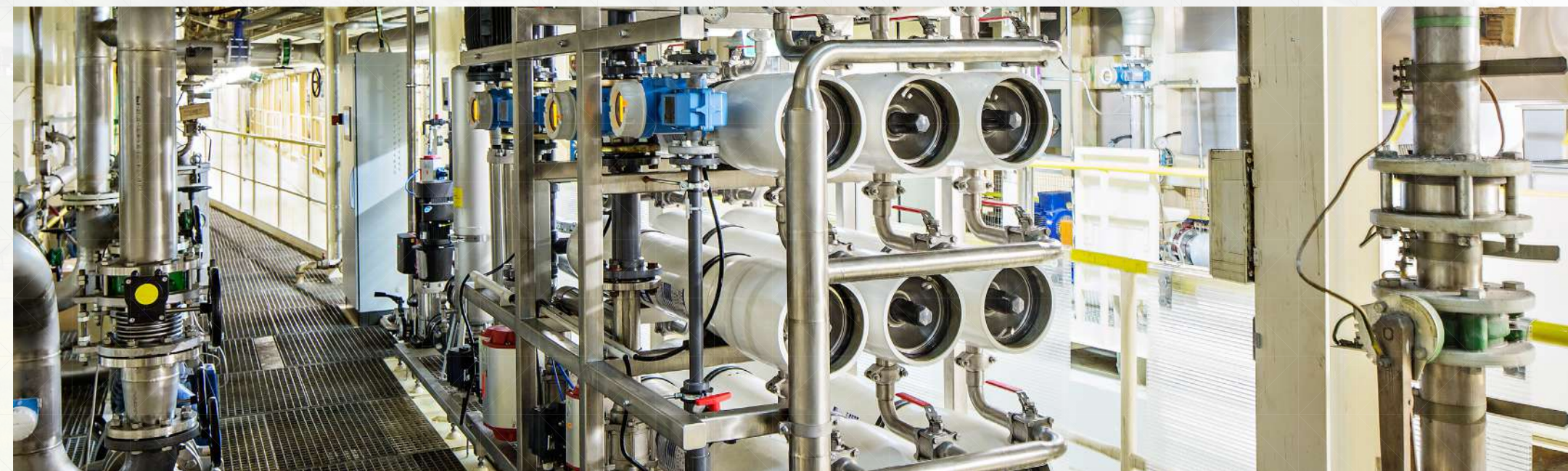
Reverzní osmóza pro výrobu demineralizované vody z oplachu karoserií v lakovně
